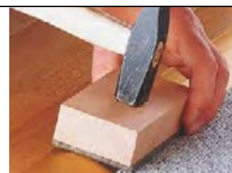
Schlagklotz mit Filzunterlage tapping block with felt underlay cale de frappe avec feutre
